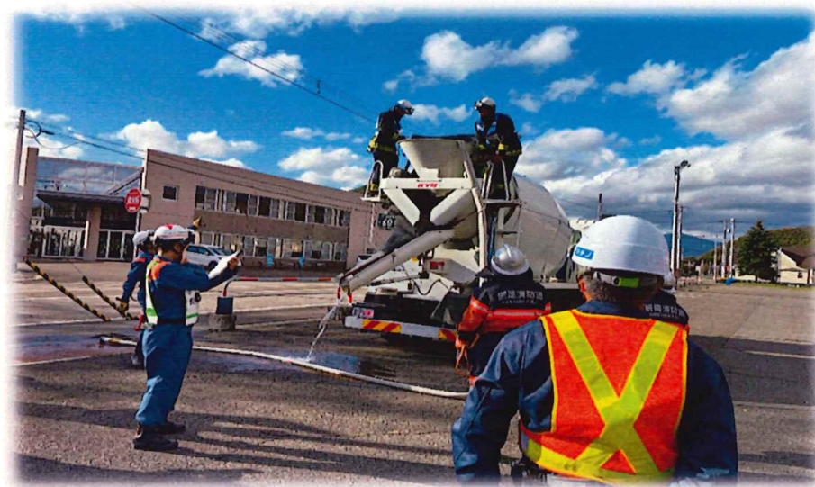
消火栓からアジ車へ給水訓練
