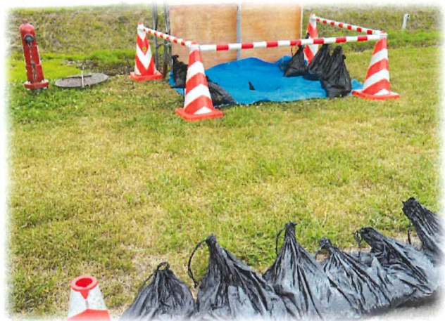
大樹町 防火水槽（投入前）
