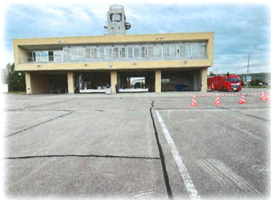
大樹町消防庁舎
