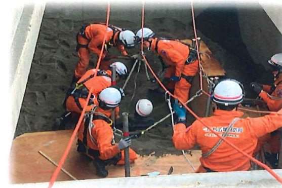
埋もれている人の廻りを手作業による掘り出し 損傷を与えないための作業
