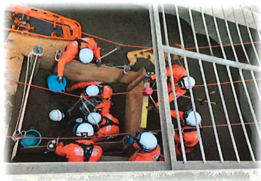
土留めをしながら 手作業が続く
