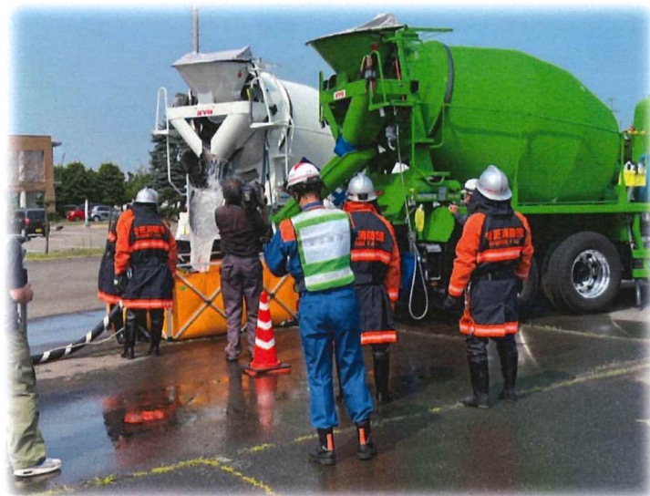
簡易水槽へ給水
